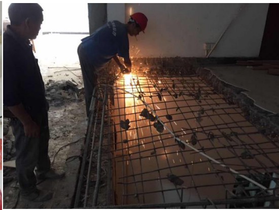
楼道改造施工
