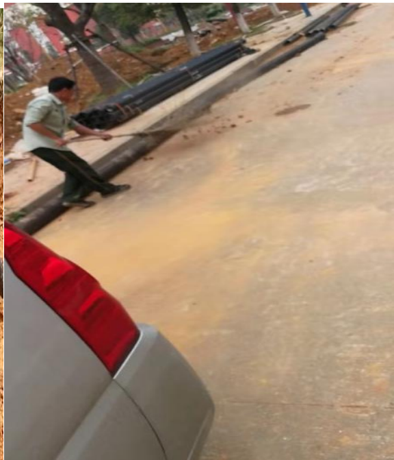
施工场地清理
