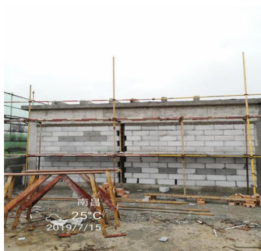
屋顶砌砖施工
