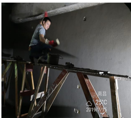
内墙粉刷施工
