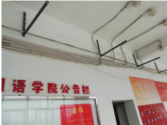
桥架安装施工
